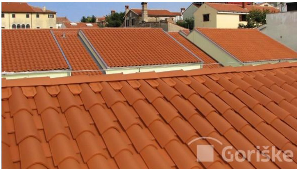
Foto 1: Posatura usando coppo liscio come coppo superiore (esempio di posa dei coppi sul tetto di una scuola)
