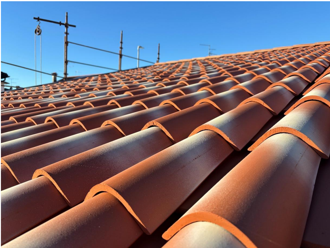
Foto 4: Posatura usando coppo grecale come coppo superiore
