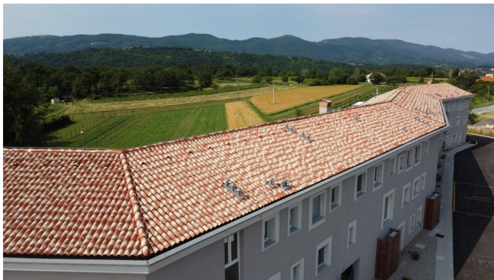
Foto 2: Posatura usando coppo liscio come coppo superiore (esempio di posa dei coppi su condominio)
