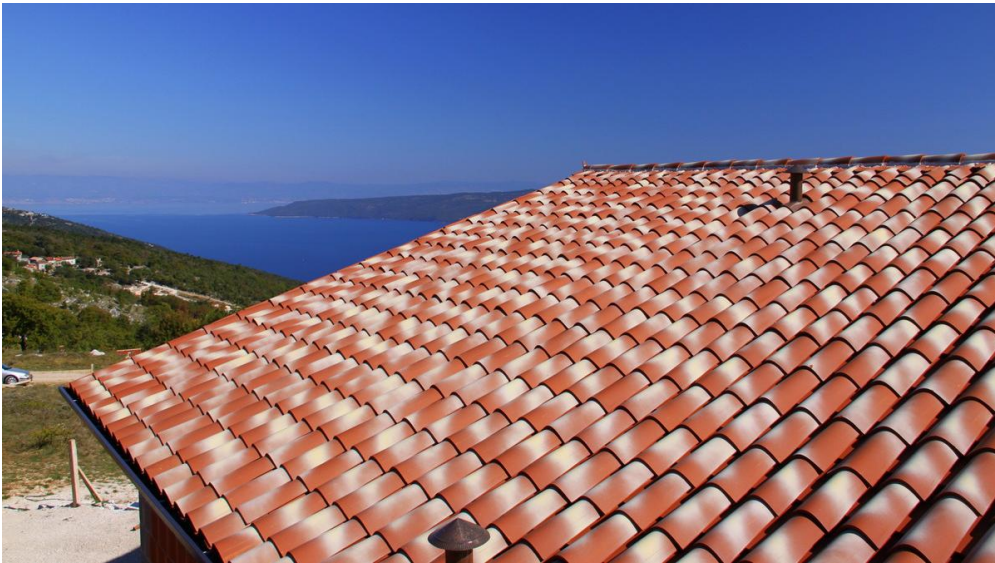
Foto 1: Posatura usando coppo liscio come coppo superiore (esempio di posa dei coppi su tetto residenziale)
