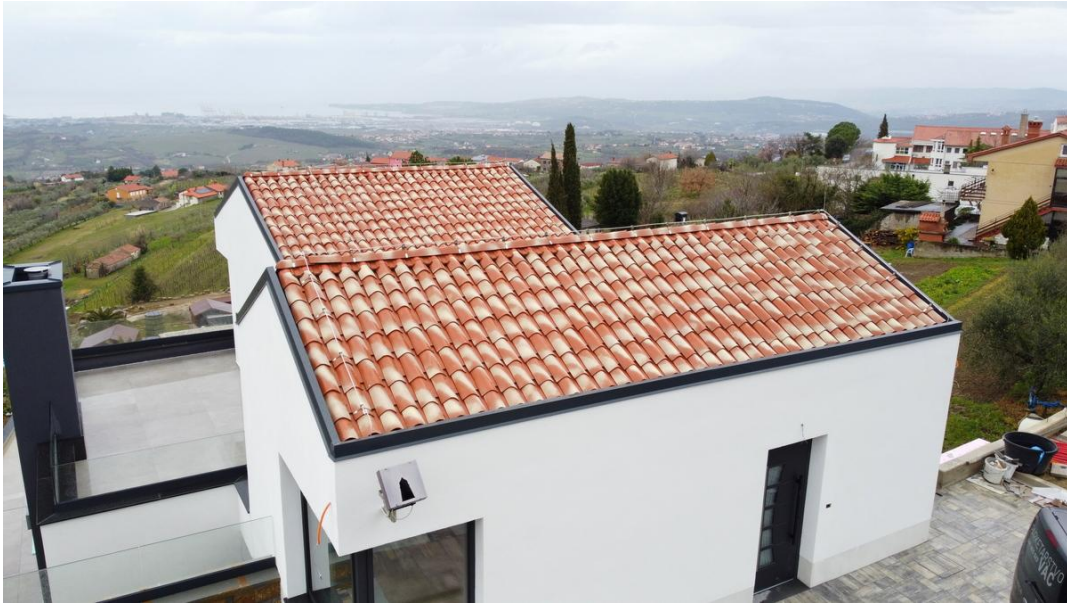
Foto 3: Posatura usando coppo grecale come coppo superiore (esempio di posa dei coppi sul tetto di una casa bifamiliare)
